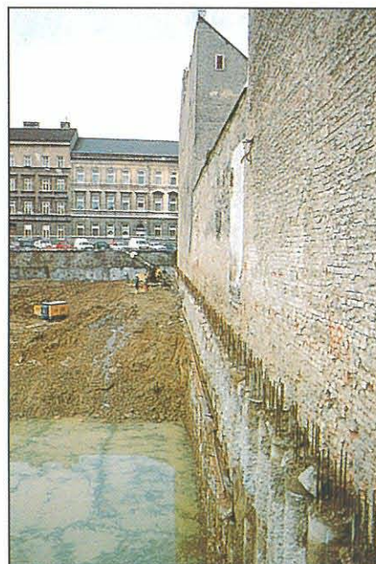
Freigelegte VDW-SOB-Pfähle mit einem Durchmesser von 400 mm für 2-geschoßigen Keller.
