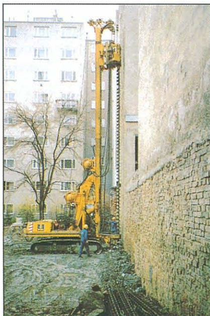
Herstellung von ca. 10 m tiefen VDW-SOB-Pfählen (Ø 330 mm) als tragende Kelleraußenwand, Platzbedarf ca. 45 cm.
